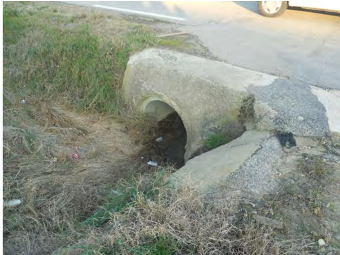
L'ouvrage d'acheminement des eaux du site SITA SUD vers ce fossé sous la route est une buse  $\phi$  800 mm, de pente inconnue. Supposons que la pente soit équivalente à celle de l'exutoire A (1,4%), soit une capacité de **1.3 m<sup>3</sup>/s environ, pouvant soulager l'exutoire A.**
